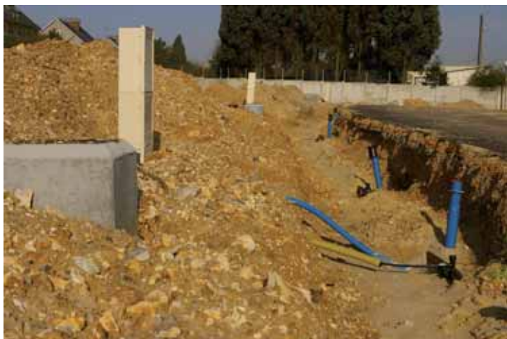
Des blindages de protection contre les éboulements doivent être mis en place dans les fouilles en tranchées d'une profondeur supérieure à 1,30 m
