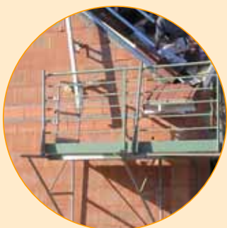
7.3 Echafaudage sur consoles
