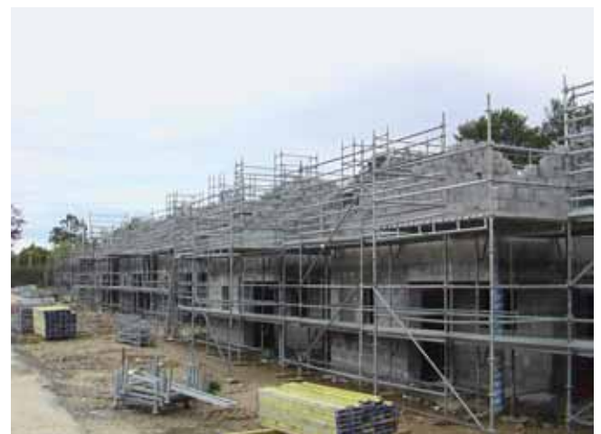
Les échafaudages périphériques de pied sont mis en commun entre les lots "gros-œuvre", "charpente", "couverture", "ravalement" et "second œuvre"
