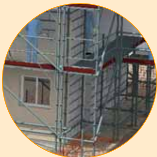
7.2 Echafaudage de pied
