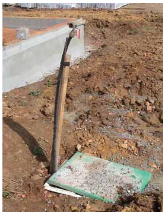
Un robinet de puisage hors gel est installé à proximité immédiate des travaux à réaliser
