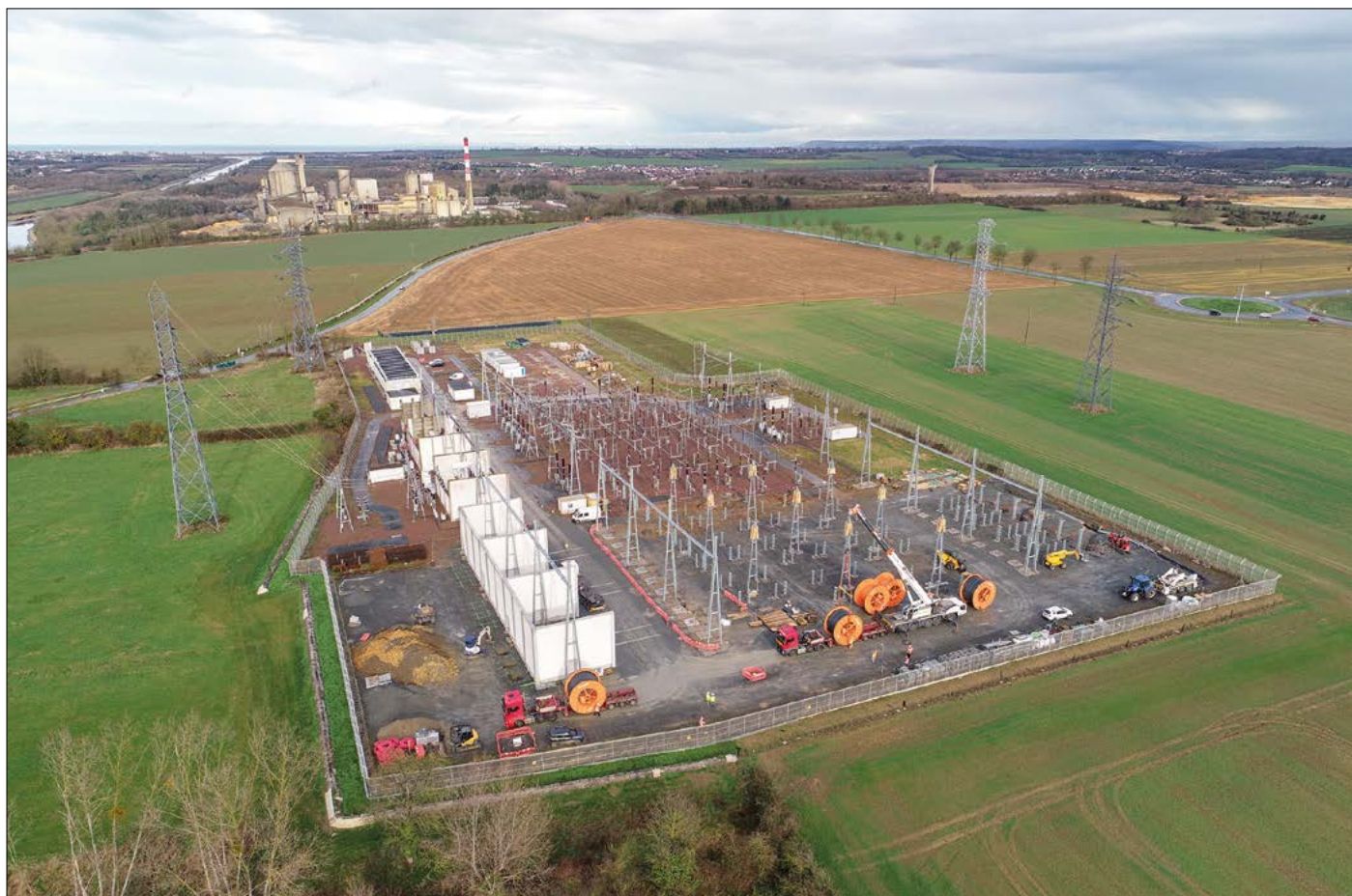
➡ Travaux d'extension du poste de Ranville
