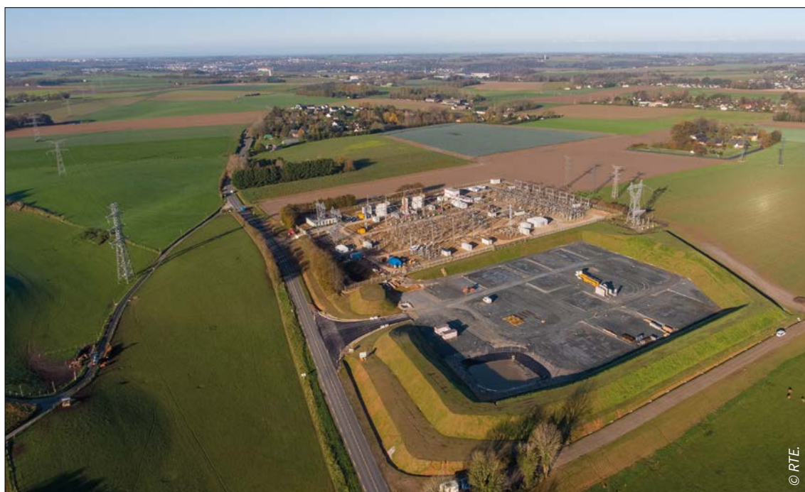
➡ Travaux d'extension du poste RTE de Sainneville-sur-Seine
