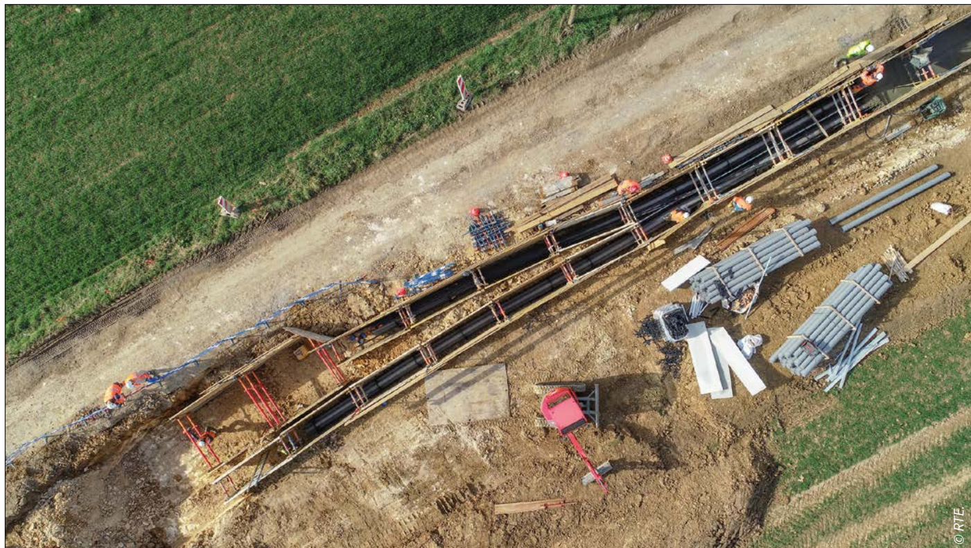
➡ Travaux de pose des fourreaux en tranchée
