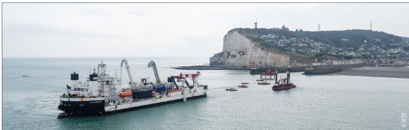
⬇ Tirage des câbles sous-marins
