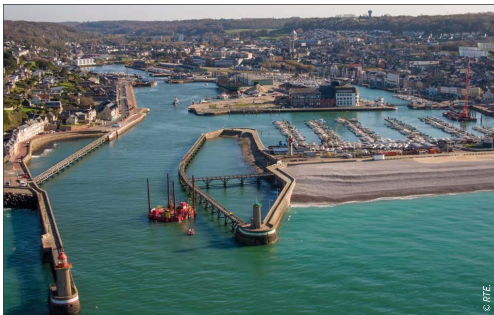
➡ Atterrage du câble sous-marin au port de Fécamp
