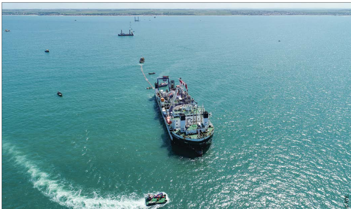
➡ Tirage des câbles sous-marins
