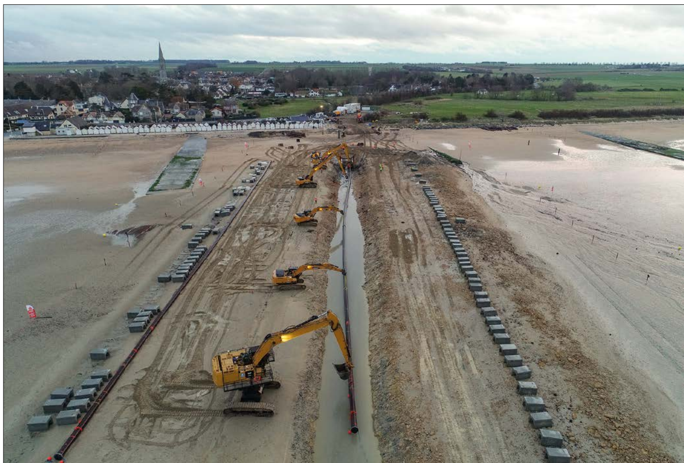
➡ Pose des fourreaux sur la plage d'atterrage à Bernières-sur-Mer
